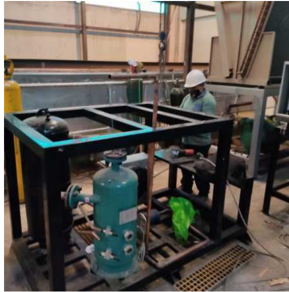
INSTALACIÓN DE EQUIPOS Y SOLDADO EN EL PRODUCTOR DE HIELO EN BLOQUES.
